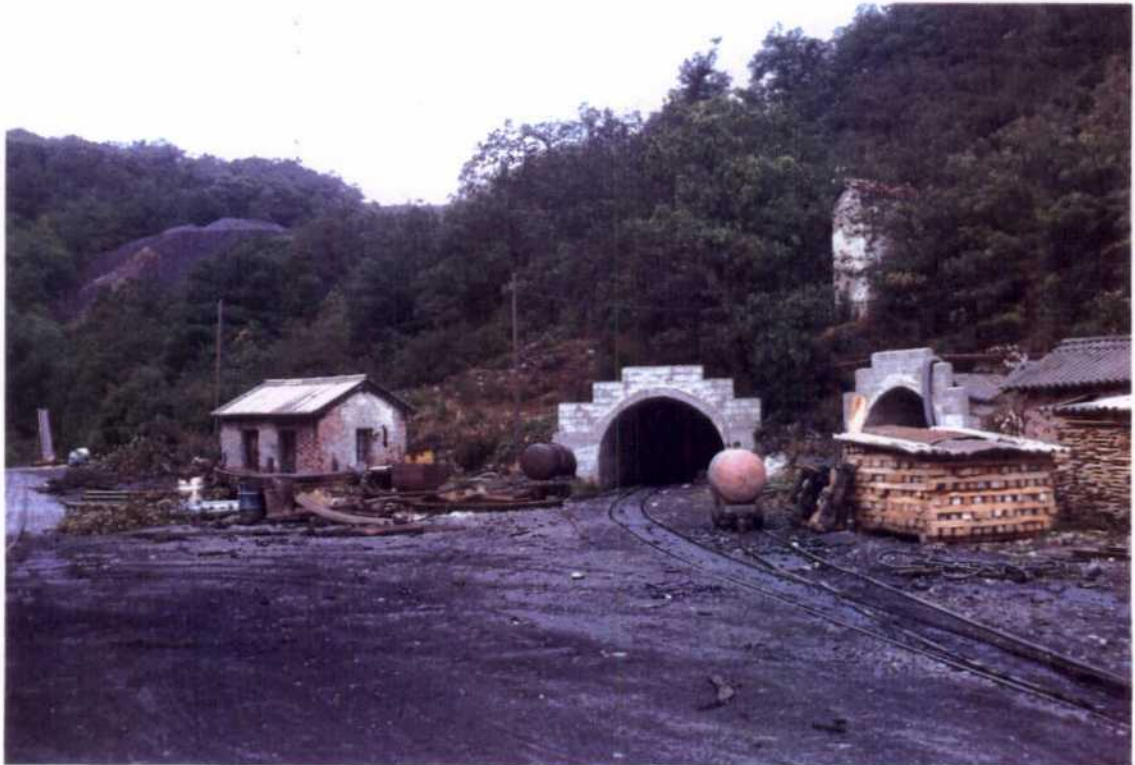
Antracitas de Velilla. Grupo Majadillas. Entrada socavón
