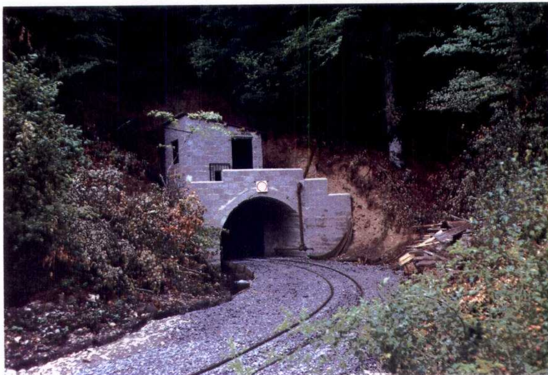
Antracitas de Velilla. Grupo Valdelabárcena. Entrada socavón
