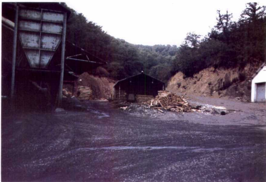
Sociedad Minera S.Luis. Mina S.Luis. Parque madera y tolva
