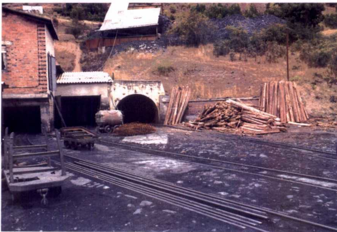
Minera Cántabro Bilbaina. Entrada socavón
